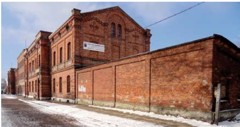
Budynek szkoły na Księżym Młynie przed remontem
