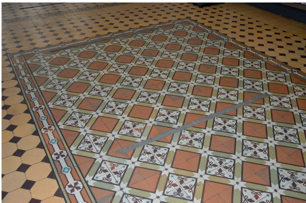
Zachowana posadzka z opoczyńskich płytek
